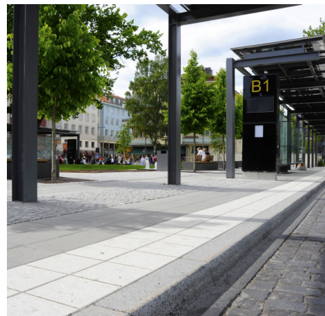
Hållplatskantstöd i granit samt kontrasterande vit platta Foto: St:eriks
