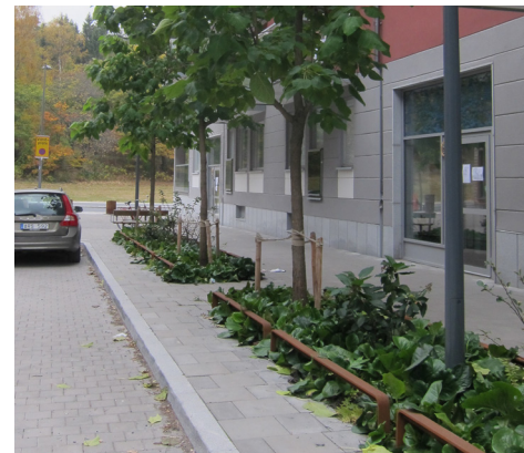
Princip för planteringsräcke i dagvattenplanteringar
