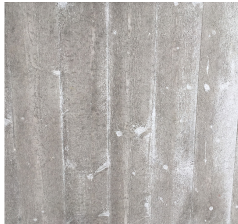
Platsgjuten betongmur där brädformen givit tydlig struktur och karaktär
